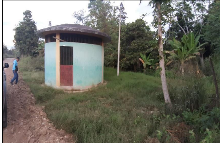
Imagen N° 46: Cámara de bombeo de aguas residuales de Bellavista
