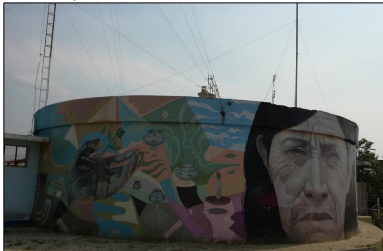
Imagen N° 20: Vista del reservorio R-1 (V=536 m 3 )
