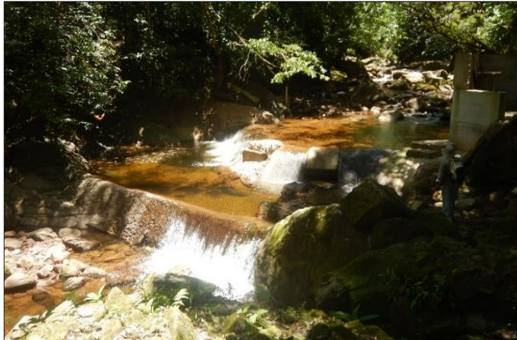
Imagen N° 5: Vista de la captación Cachiyacu
