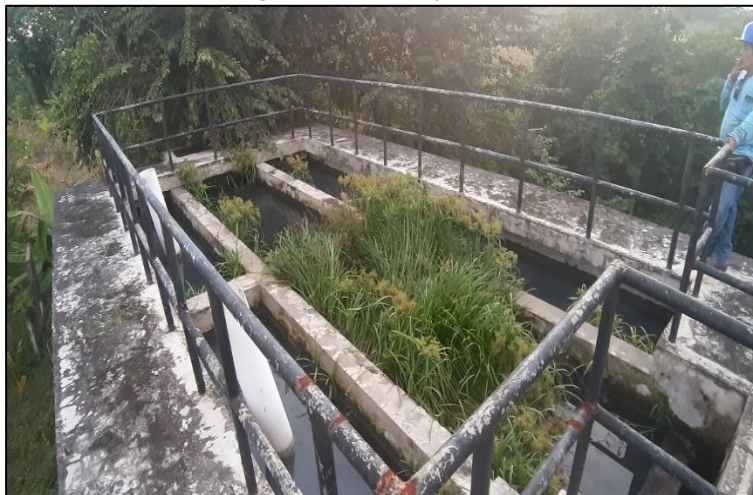
Imagen N° 49: Tanque Imhoff
