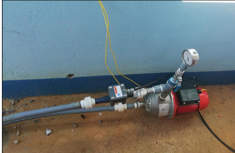
Imagen N° 19: Vista de bomba para la desinfección
