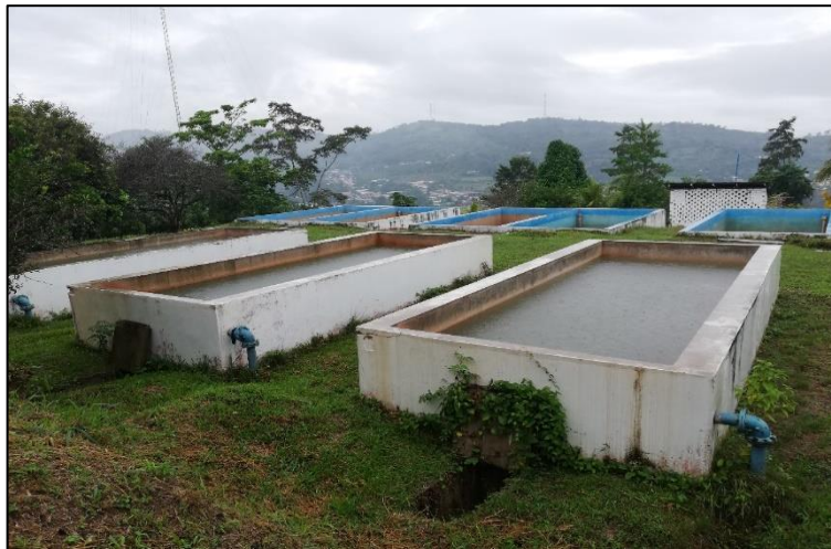
Imagen N° 34: Planta de tratamiento de agua potable de San José de Sisa
