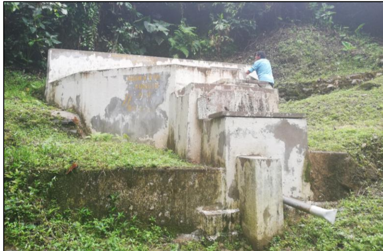
Imagen N° 13: Vista de la captación Mishquiyacu
