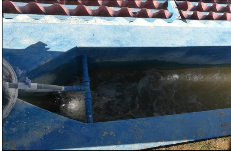
Imagen N° 15: Vista de los sistemas de Coagulación de la PTAP Lamas
