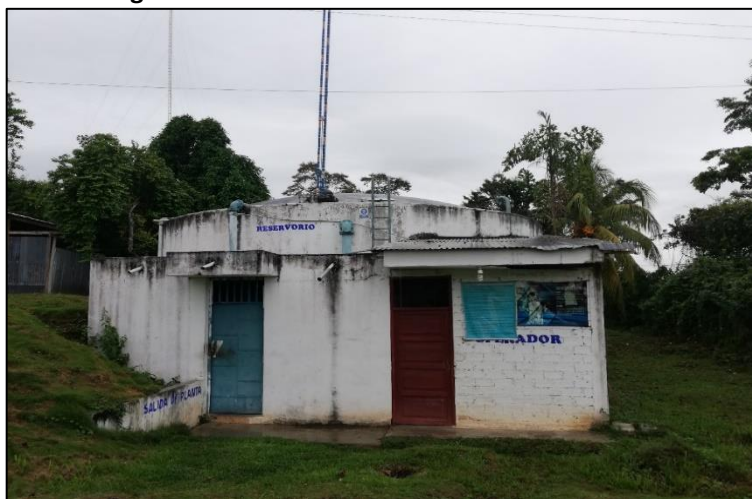
Imagen N° 35: Reservorio R-500 de San José de Sisa
