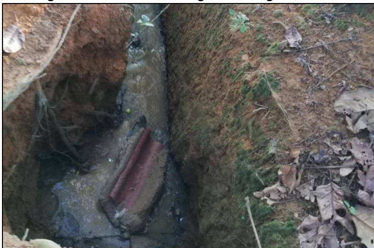
Imagen N° 24: Vista de descarga N° 2 de aguas residuales
