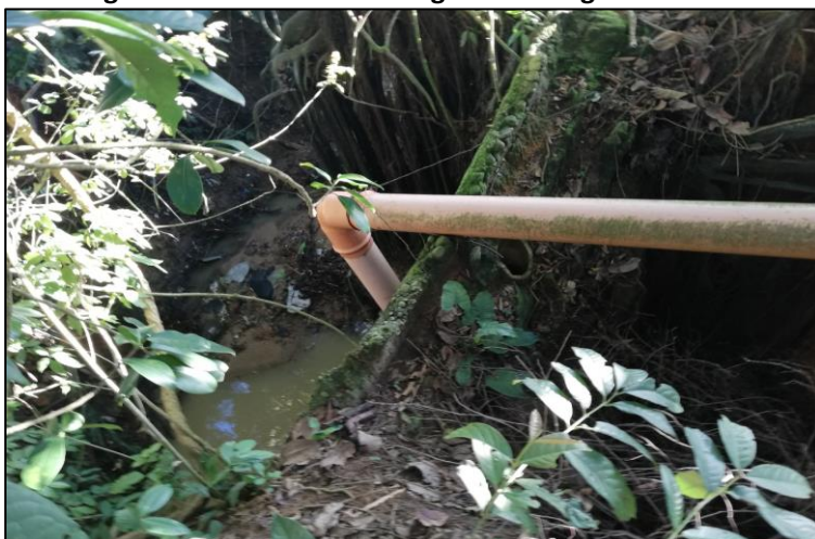
Imagen N° 23: Vista de descarga N° 1 de aguas residuales
