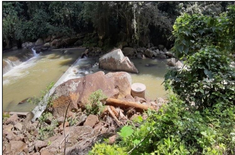
Imagen N° 26: Captación de Saposoa
