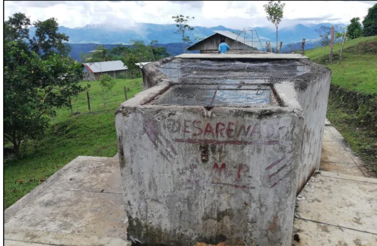
Imagen N° 14: Vista del desarenador N°1
