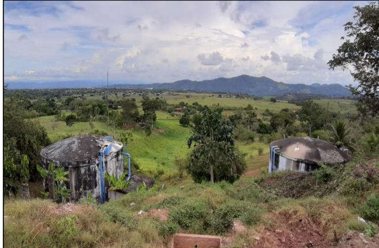
Imagen N° 41: Reservorio Antigo R-500 m 3 y Reservorio Nuevo R-500 m 3
