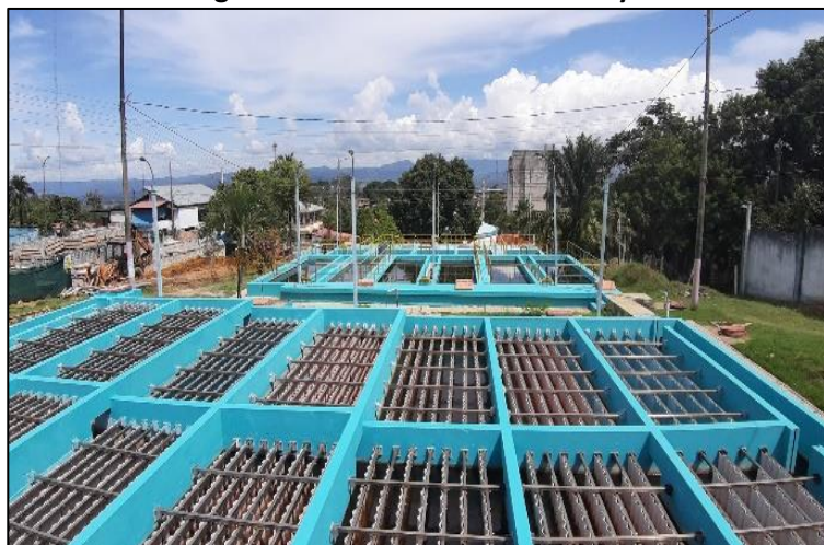
Imagen N° 8: Vista de la PTAP Cachiyacu
