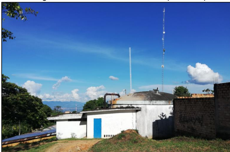
Imagen N° 21: Vista del reservorio R-1 (V=500 m 3 )
