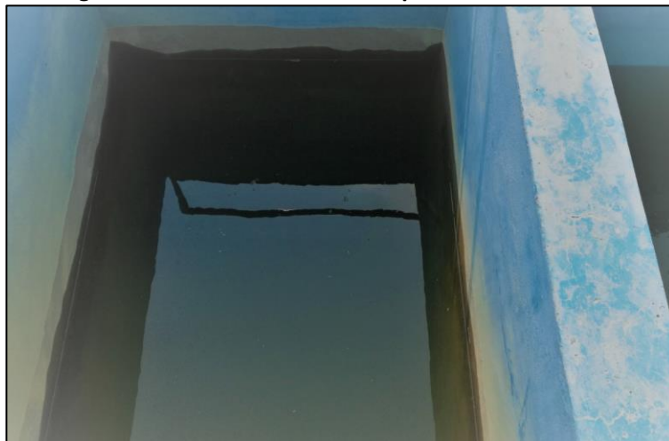
Imagen N° 18: Vista de los filtros rápidos de la PTAP Lamas
