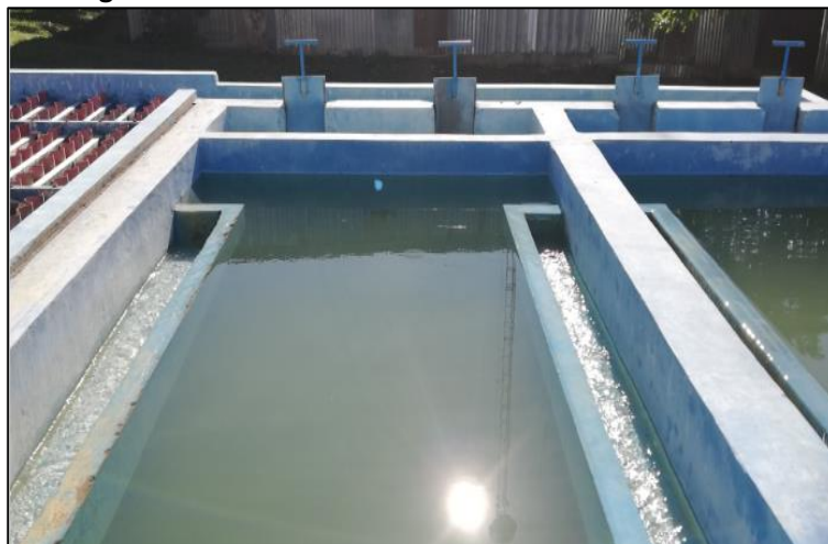
Imagen N° 17: Vista de los decantadores de la PTAP Lamas
