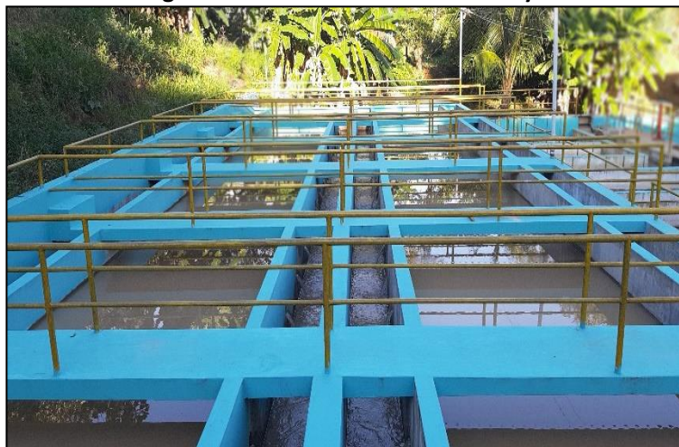
Imagen N° 9: Vista de la PTAP Ahuashiyacu
