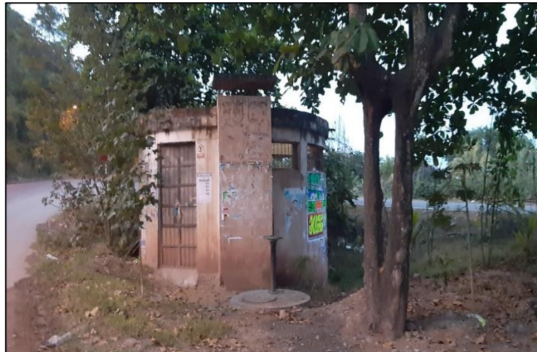
Imagen N° 47: Cámara de bombeo de aguas residuales de Porvenir
