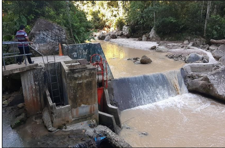
Imagen N° 6: Vista de la captación Ahuashiyacu
