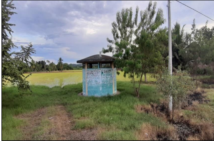
Imagen N° 48: Cámara de bombeo de aguas residuales de Limón
