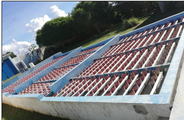
Imagen N° 16: Vista de los floculadores de la PTAP Lamas
