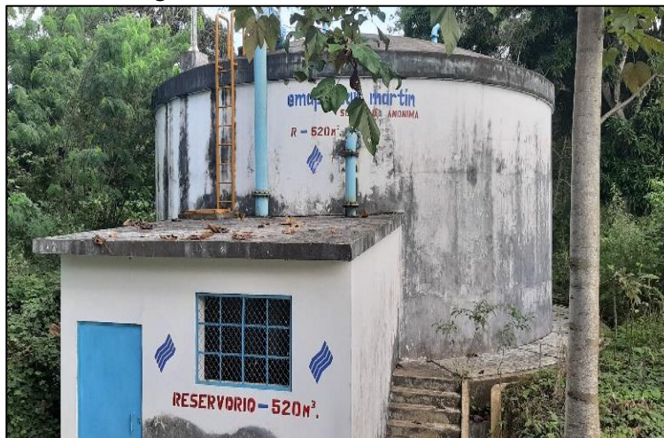
Imagen N° 10: Vista del reservorio R-520 m 3
